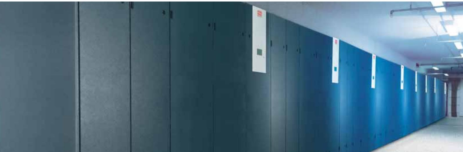
Le CyberAir 2 de STULZ permet de disposer les climatiseurs de manière centralisée ou de les répartir en divers endroits de la salle. Chaque climatiseur est doté d'une intelligence propre. Jusqu'à 20 climatiseurs peuvent être interconnectés en réseau.
